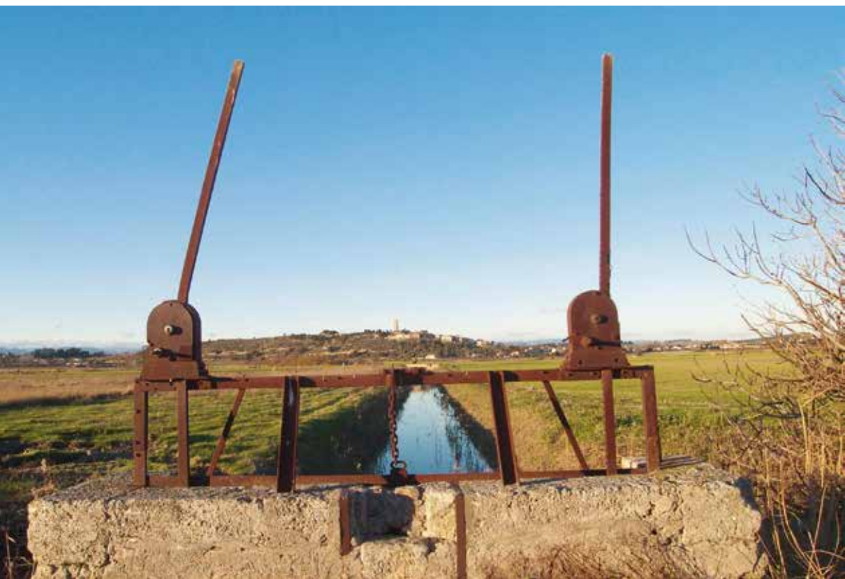
L'étang de Montady : martelière, grand fossé de drainage et village de Montady, à l'arrière-plan.
