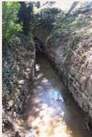
Fig. 36 - Sortie de la galerie souterraine de l'étang de Montady. Le lieu-dit, les Traoucats (trouées), se réfère aux puits creusés à intervalles réguliers pour construire la galerie, mais aussi aux trois sorties successives à l'air libre.
